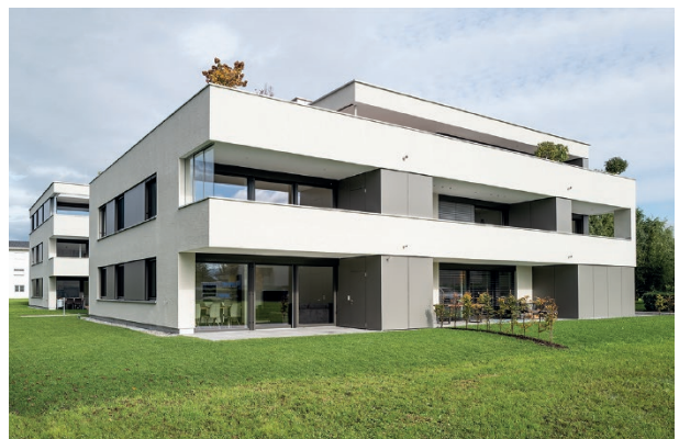
Wohnanlage Schnepfenweg, Hard
