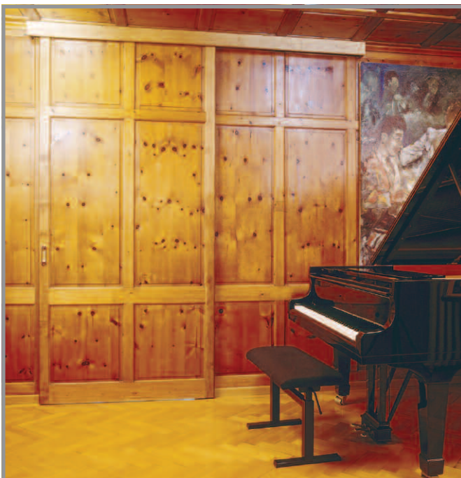
nachträglicher Einbau einer Schiebetüre
